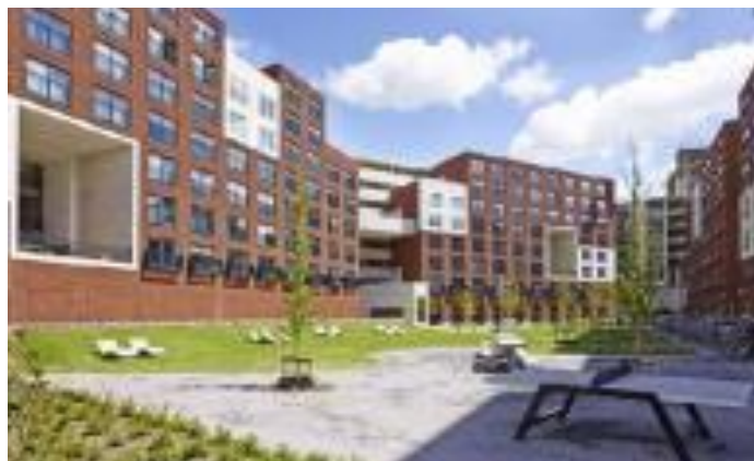
Fuente: Exterior de la Villa Mokum, kampman architecten, 2014 (citado en Narvaez, sf)
