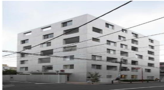
Ilustración 78 Exterior de vivienda en viviendas de Nerima, en Ja-pón,
