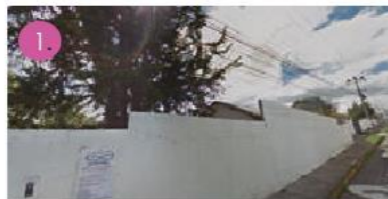
MURO A DESNIVEL
