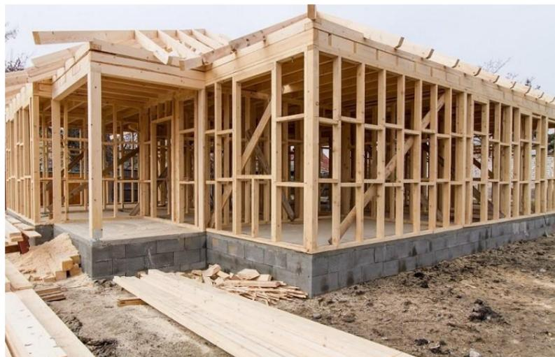
Ilustración 13 – Sistema constructivo de madera
