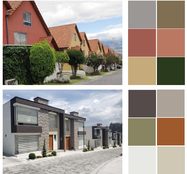
Figura 32 :Fachadas de Complejos habitacionales Fuente :Google Maps / Visualizaciones de Satélite (2021)
