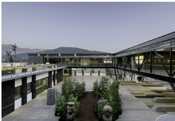
Figura 6. Centro Cultural El Tranque / BIS Arquitectos Fuente: Vargas, 2019
