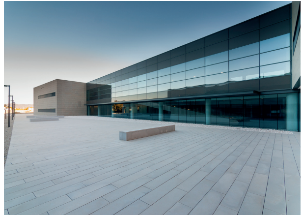
Figura 15: Hospital General de la Línea de la Concepción Fuente: (Alejandro Gonzáles, 2018).
