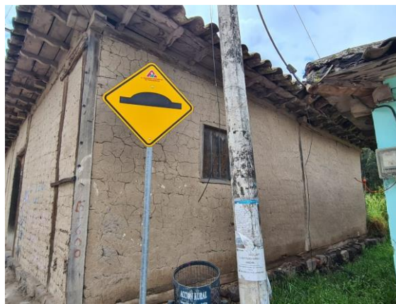
Figura 16. Estabilización de muros
