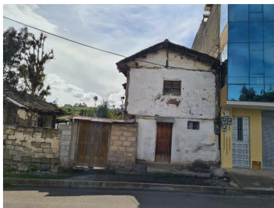
Figura 49. Intervención para estabilización
