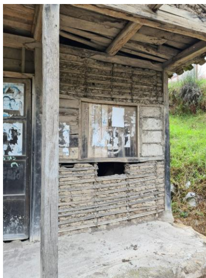
Figura 25. Intervención para estabilización
