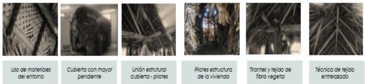
Figura20. Sistemas constructivos de nativos de Puyo
