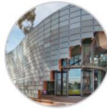
Recubrimiento Paneles metalicos
