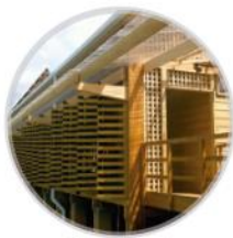
Estructura de madera Columnas, vigas, viguetas
