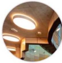
Cubierta Hormigon Macizo
