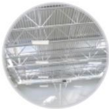
Estructura metálica Cerchas Warren
