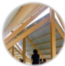
Cubierta Paneles de Zinc
