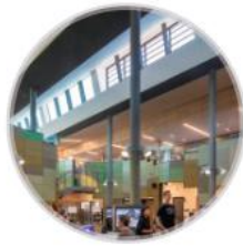
Estructura Mixta Columnas metalicas
