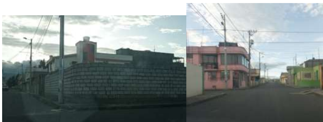
Áreas deterioradas. Fachada urbana irregular, aceras y bordillos en deterioro.
