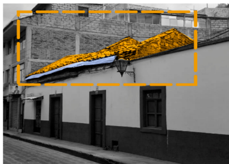
Cubierta inclinada con teja de barro y zinc
