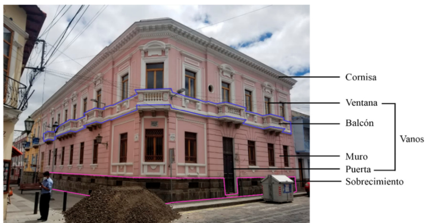
Elementos constructivos de una vivienda patrimonial de 2 pisos del centro histórico de Latacunga
