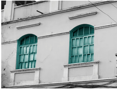
Ventana alargada con arco y marco de madera
