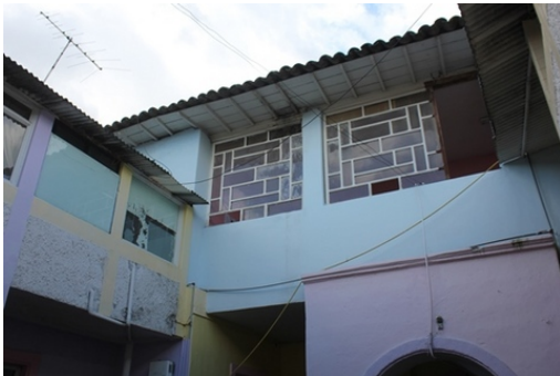
Descripción:Detalle de las adecuaciones interiores, segunda planta remodelada.
