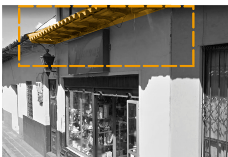
Cubierta inclinada con teja Eternit decorativa ondulada
