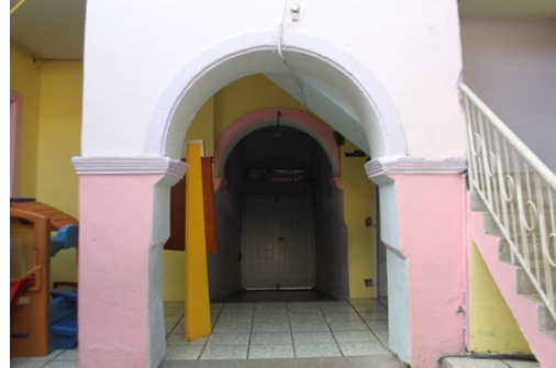
Descripción:Detalle de las pilastras interiores.
