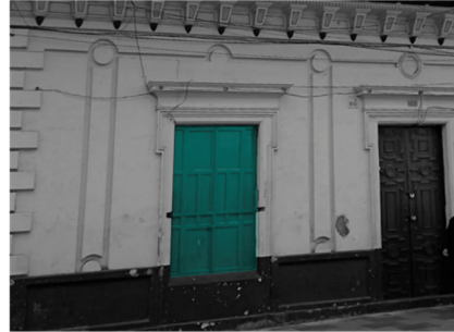
Ventana alargada rectangular recubierta de madera
