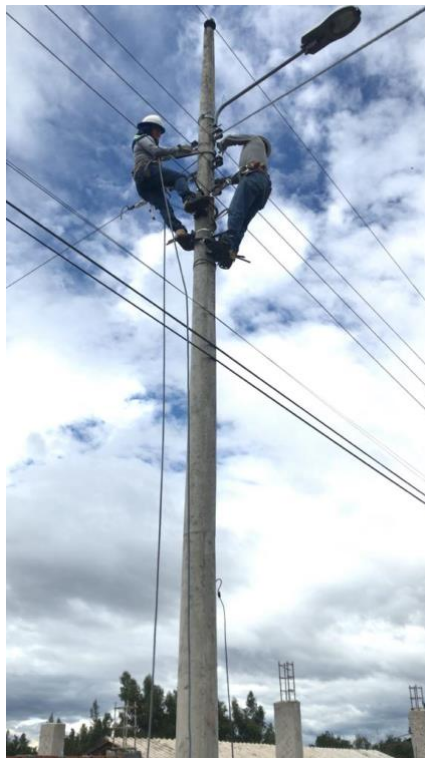
Ilustración 172: Templado de las líneas eléctricas
