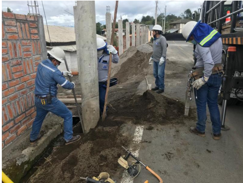
Ilustración 169: Reubicación del poste de concreto Elaborado por: Jonathan Jara
