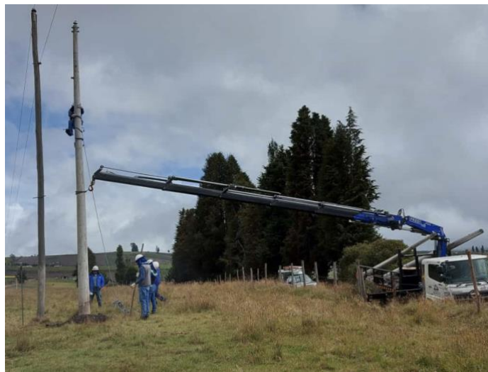
Ilustración 83: Colocación e instalación eléctrica de un poste de Media tensión Elaborado por: Jonathan Jara
