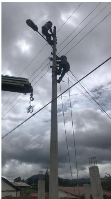
Ilustración 153: Desconexión de los conductores eléctricos del poste
