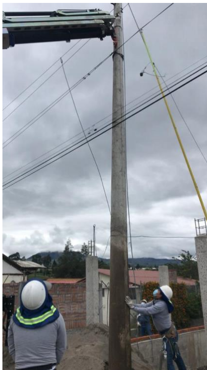
Ilustración 162: Traslado del poste a una nueva ubicación
