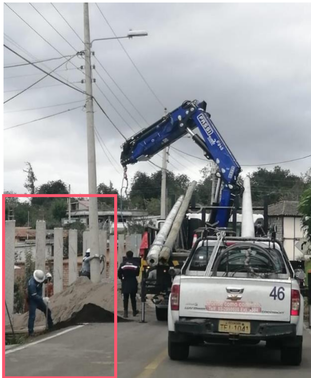
Ilustración 120: Excavación del agujero de 2,5 metros
