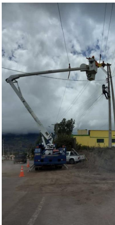
Ilustración 88: Cambio de aislantes tipo pines Elaborado por: Jonathan Jara
