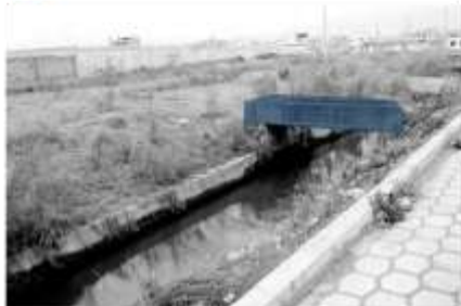
Puentes peatonales sin barreras y sin espacio de conexión
