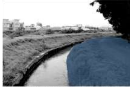
Zonas sin circulación peatonal y barreras de seguridad
