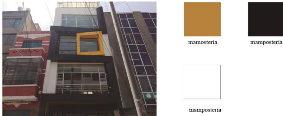
Imagen 50. Colores Edificio calle Sucre y Montalvo.
