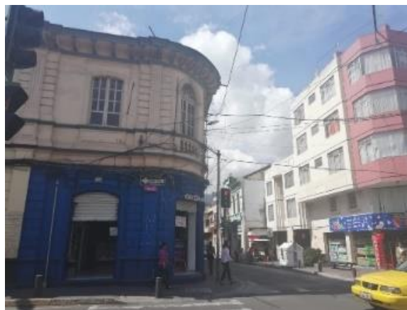
Imagen 1: Edificaciones pintadas en planta baja de varios colores.
