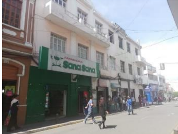
Imagen 2: Edificaciones pintadas en planta baja de varios colores dependiendo su uso.
