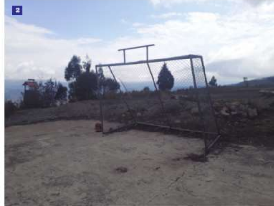
Cancha de hormigón con arcos metálicos, sin cerramiento.
