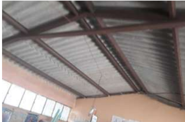
Gráfico N°24. Ejemplo de estructura metálica con perfil tipo “G” para cubierta en el Centro Educativo Intercultural Bilingüe “Galte Yaguachi”
