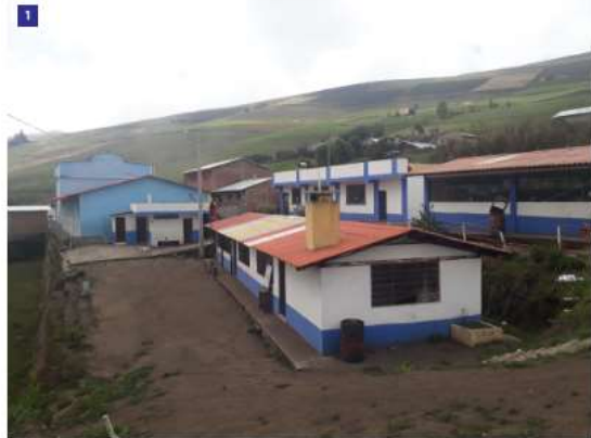
Se observan 2 bloques de hormigón armado, y uno de estructura metálica, mamposterías de ladrillo enlucido y pintado, pero solo 2 poseen cubiertas de fibrocemento, y el restante de losa armada. Se identificaron 4 aulas y una dirección. En la parte mas lejana se encuentran los servicios sanitarios.
