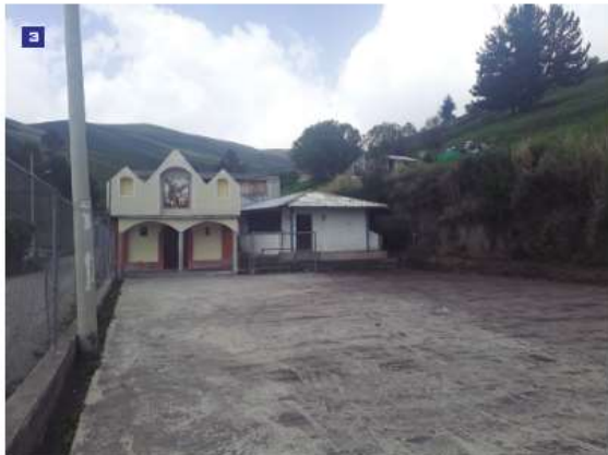
Cancha deportiva de cemento, aula hexagonal de estructura de hormigón armado, mamposterías de ladrillo, cubierta metálica, piso de entablado, puertas y ventanas de estructura metálica. Al lado izquierdo se encuentra una iglesia.
