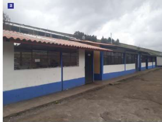
Se visualizan 3 Bloques de aulas, de mampostería de ladrillo cocido, 1 de estructura metálica y 2 de hormigón armado, con cubiertas de fibrocemento
