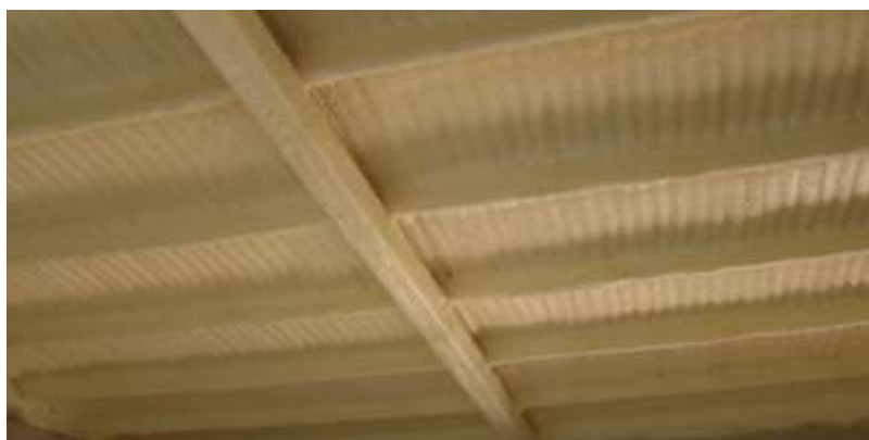
Figura N°46. Referente de acabado final del recubrimiento de poliuretano sobre cubierta preexistente.
