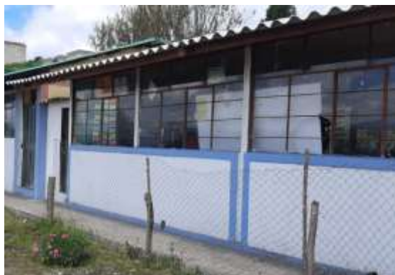
Gráfico N°22. Ejemplo de aula con metálica en columnas y cubierta con planchas de fibrocemento en escuela “Miguel Lasso Guzñay”
