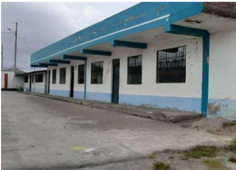
Gráfico N°21. Ejemplo de estructura de hormigón armado con losa armada en la Unidad Educativa “Fernando Daquilema”
