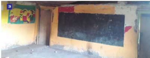
Aula de una planta, en estructura metálica y mampostería de ladrillos, cubierta de placas de fibrocemento, puerta y ventanas de estructura metálica. Bloque de 2 pisos de aulas de estructura y losa de hormigón armado, con cubiertas de fibrocemento; cancha de hormigón.
