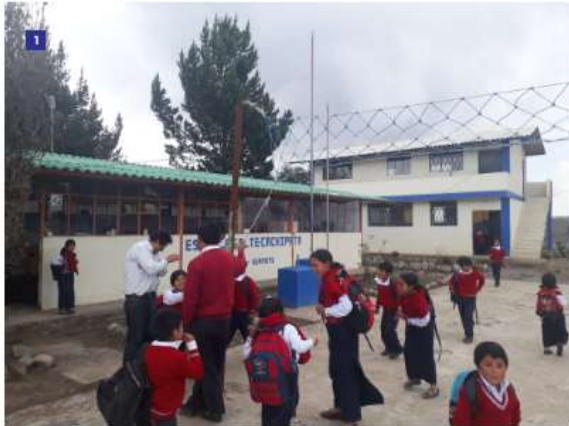
Aula de una planta, en estructura metálica y mampostería de ladrillos, cubierta de placas de fibrocemento, puerta y ventanas de estructura metálica. Bloque de 2 pisos de aulas de estructura y losa de hormigón armado, con cubiertas de fibrocemento; cancha de hormigón.
