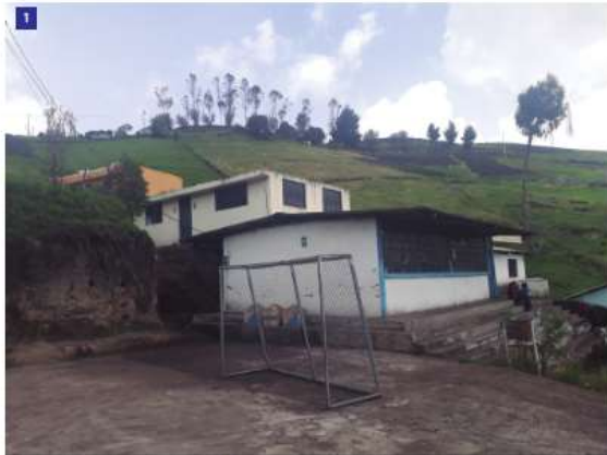
Bloques de aula de estructura metálica, mampostería de ladrillo, cubiertas de fibrocemento, sin tumbado. Dirección de estructura y losa de hormigón armado; ambas edificaciones con puertas y ventanas con marcos metálicos y mamposterías de ladrillo.
