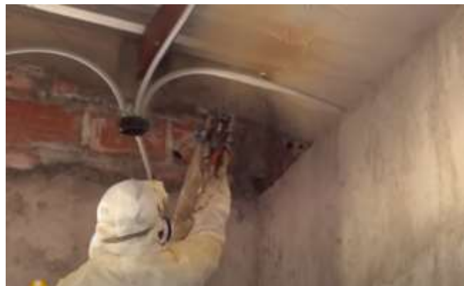
Figura N°45. Referencia de colocación de espuma de poliuretano
