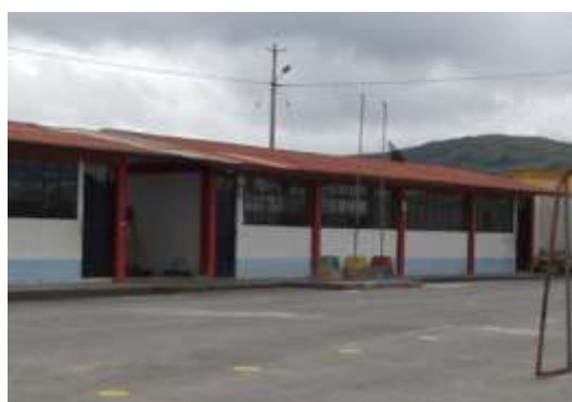
Gráfico N°23. Ejemplo de bloque de aulas con mamposterías de ladrillo enlucido en la Unidad Educativa “Fernando Daquilema”
