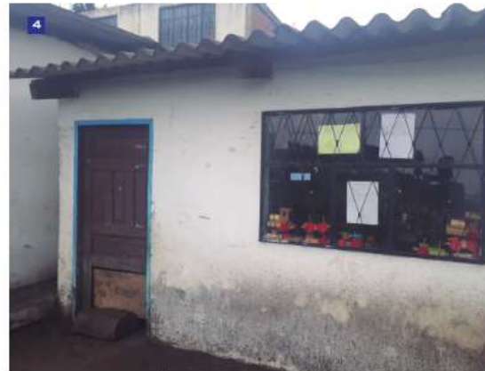
Aula de estructura de hormigón armado, mamposterías de ladrillo, puerta de madera, marcos de ventana de estructura metálica, cubierta de placas de fibrocemento, sin tumbado y piso de hormigón visto.
