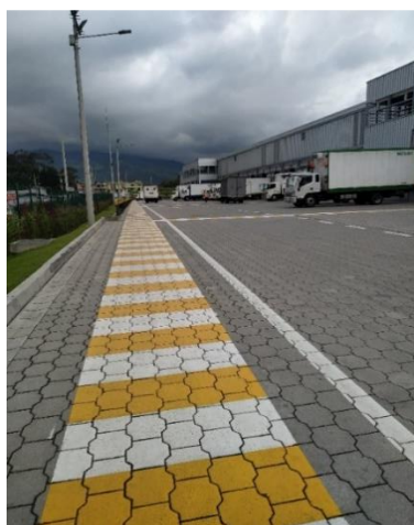
Figura 8: Compuertas de recepción de productos perecibles.
