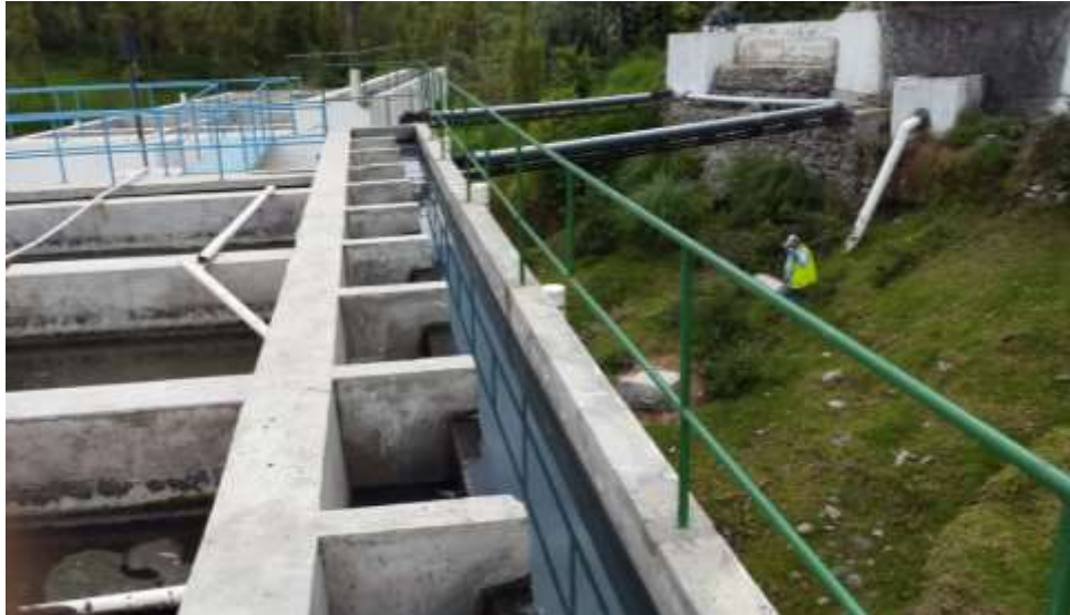
Imagen N°6. PTAR Shuyurco desde su parte superior.
