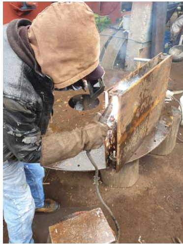
Soldadura de piezas
