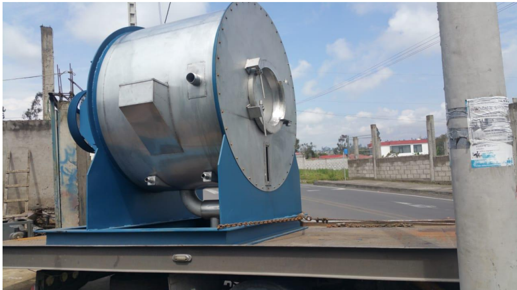
Llegada de la máquina para su posterior instalación
