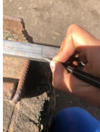
Corte de tubos
