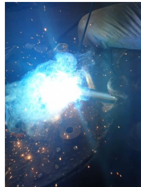
Soldadura del tambor
