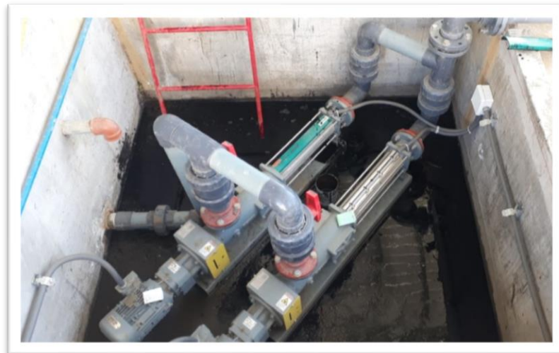
Figura 20: Unidad de Flotación de Fangos Fuente: Memoria Descriptiva de la PTAR
