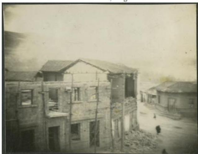
Imagen 3. Edificaciones de Ambato, luego del terremoto
