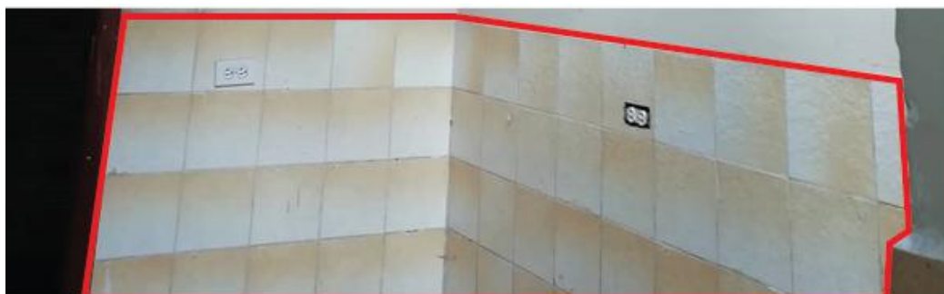
IMAGEN 59: REVESTIMIENTO INTERIOR DE LOS ESPACIOS COMPLEMENTARIOS
