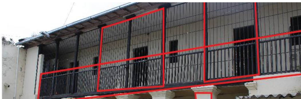
IMAGEN 53: ELEMENTOS DE TERMINACIÓN DEL PABELLÓN
