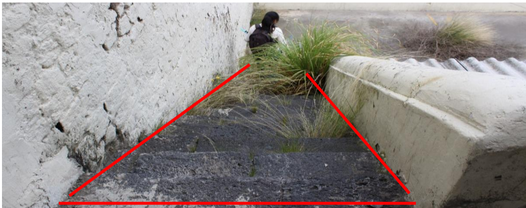
IMAGEN 64: GRADAS DEL PABELLÓN - CELDAS
