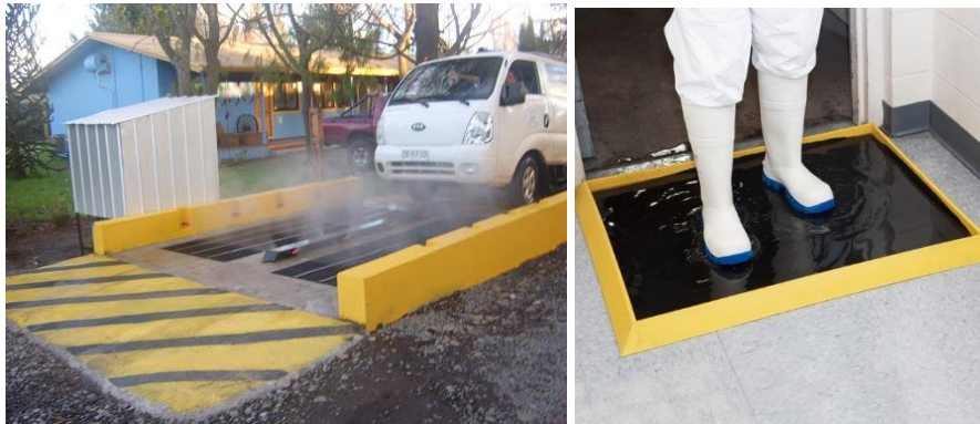
Imagen 8: Instalación de Prediluvio / Rodiluvio
