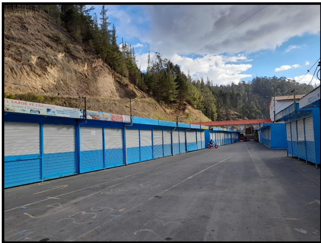
Imagen 122: Fotografía Locales Comerciales del Santuario
