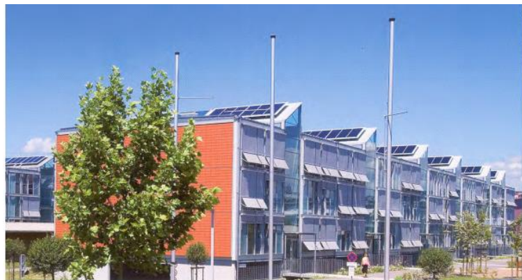
Gráfico 6: Sistema de energía solar en el ecobarrio de Linz, Austria. Fuente: THerzog, (2005)
