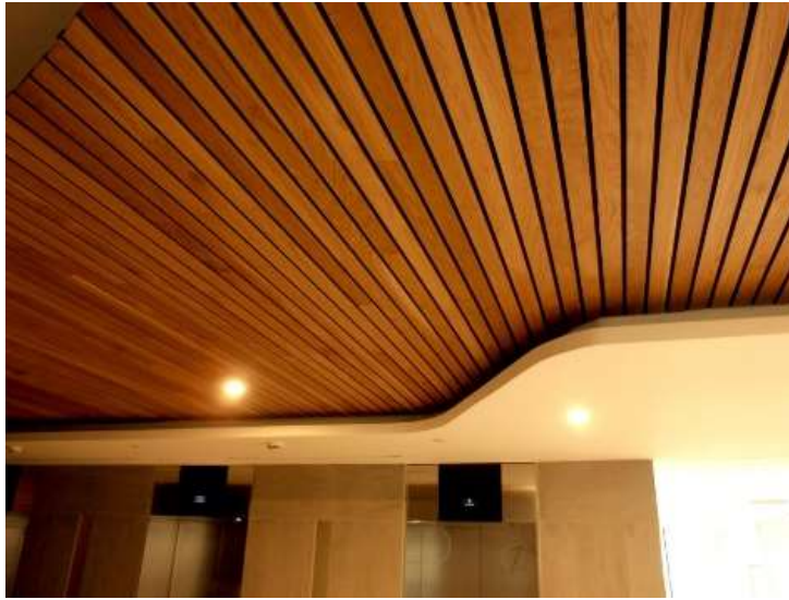
Figura 83 Cielo raso en fibra de vidrio
