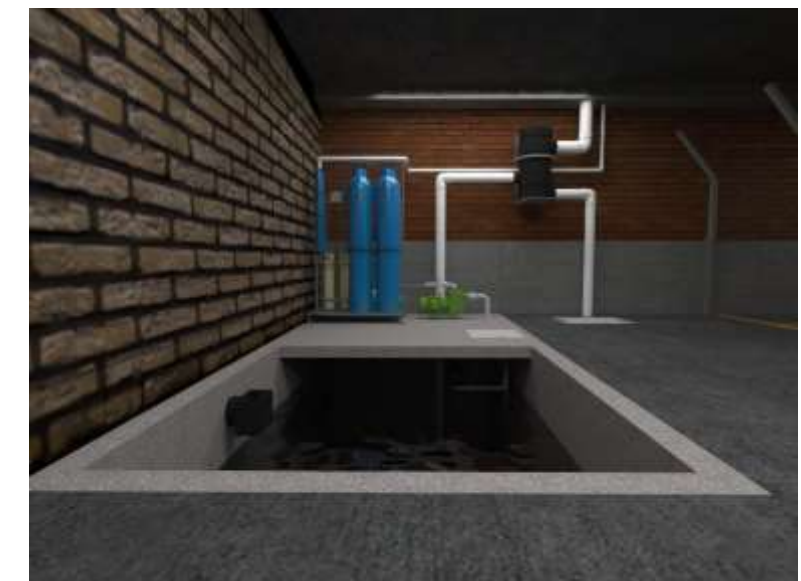
Figura 98 Cisterna Fuente: (hidropluviales, 2019)
