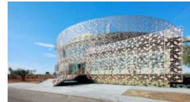
Figura 96 Edificio Corporativo de Oficinas del Centro Tecnológico de Hispasat Fuente: Plataforma arquitectura
