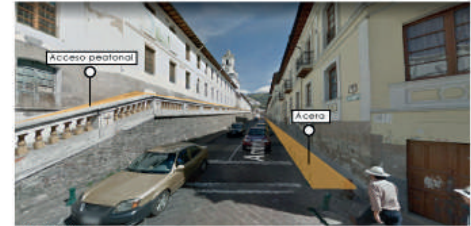
CALLE AMBATO: Aceras con dimensión mínima, Acera de un solo lado, Acceso peatonal en site
