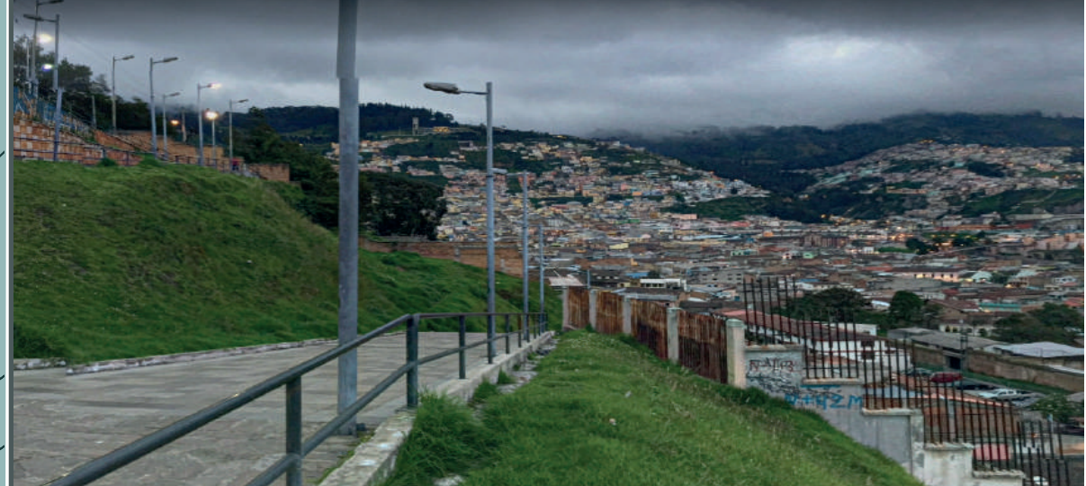
En la continuación de las escalinatas de la García Moreno se mantiene el uso de muros ciegos los cuales tienen una continuidad para la seguridad de las residencias.
