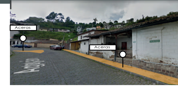
Vehículos en Acercas La problemática de las aceras en esta parte es que no existe un espacio adecuado para la circulación del peatón irrumpiéndose por vehículos estacionados dentro de las aceras
