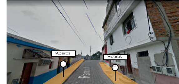
Acercas en buen estado Una potencialidad de esta parte de la calle Agoyán es que su aceras han sido diseñadas con un ancho adecuado para un flujo de personas alto, es por esto que se pueden generar varias actividades dentro del mismo espacio.
