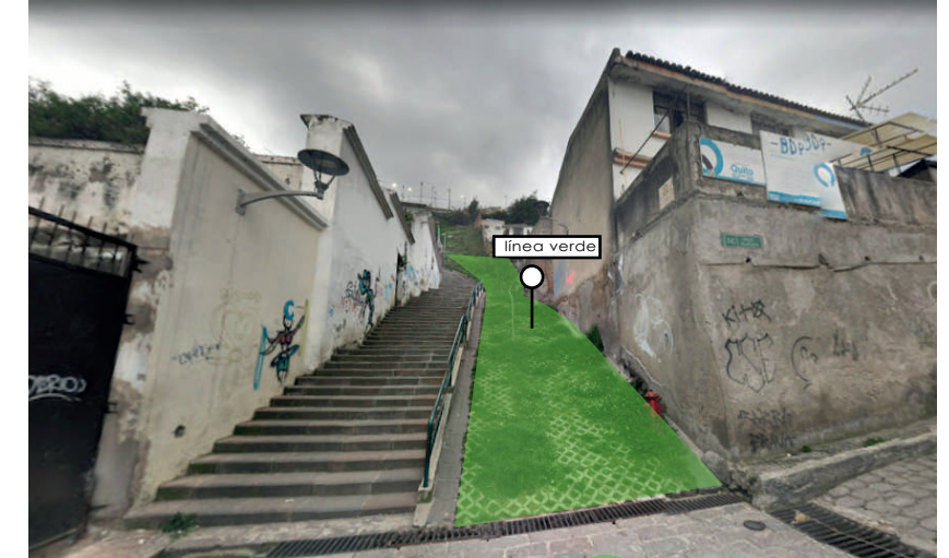
ESCALINATAS GARCÍA MORENO 1 Implementación de línea verde en las escalinatas
