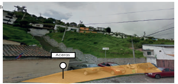
La problemática de las aceras en esta parte es que no existe un espacio adecuado para la circulación del peatón irrumpiéndose por vehículos estacionados dentro de las aceras
