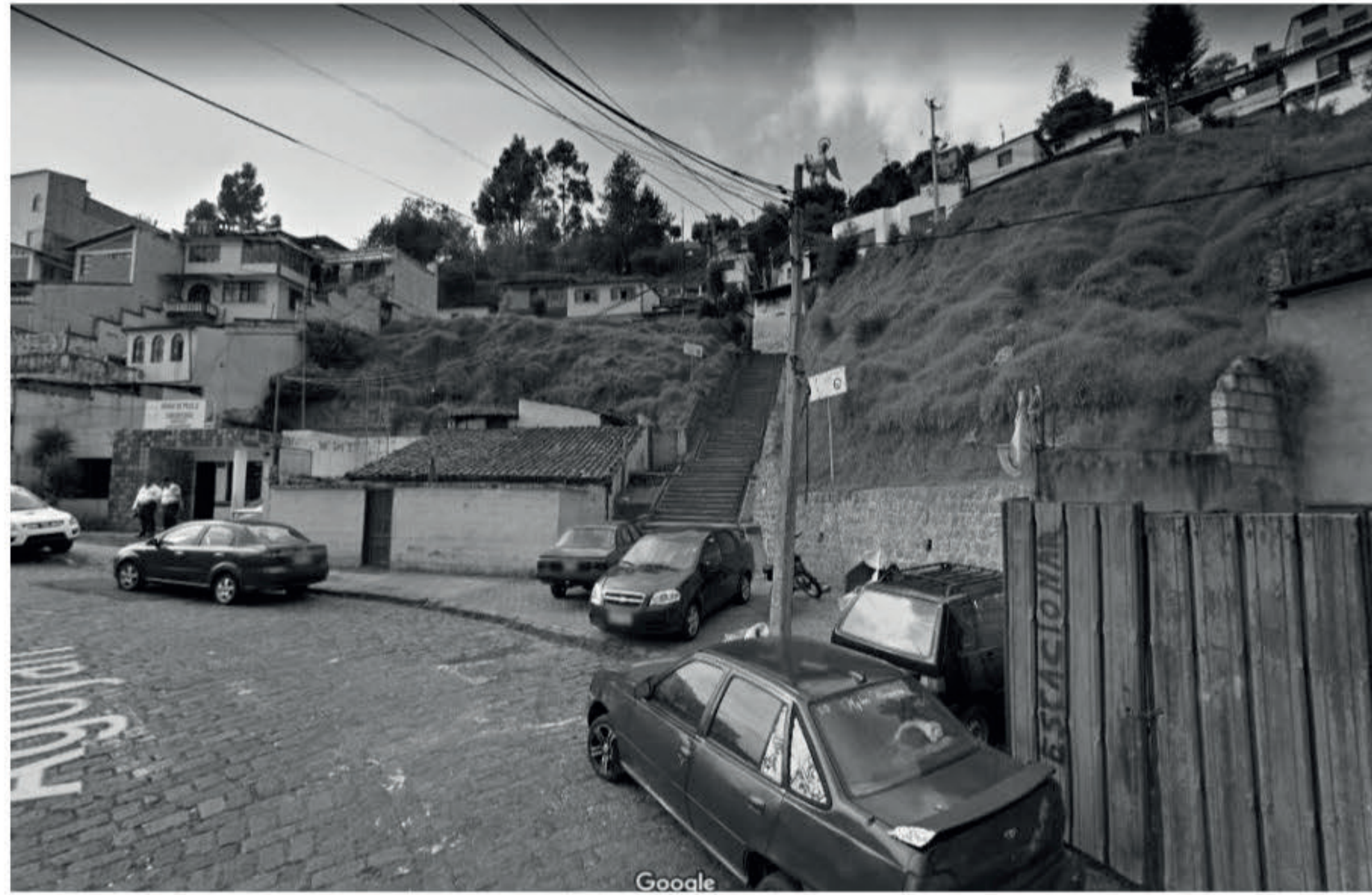
ESTADO ACTUAL " ESCALINATAS AGOYÁN"
