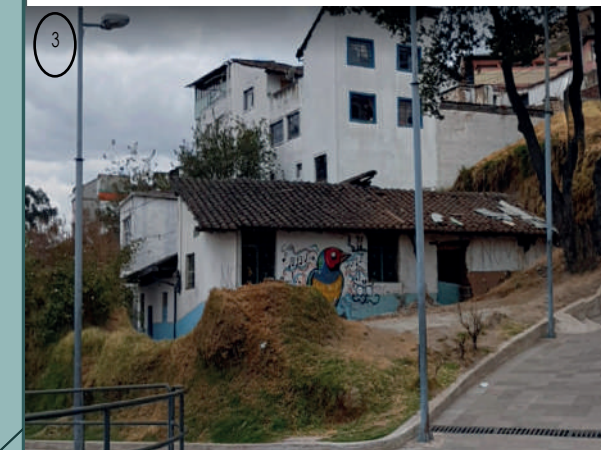
Vivienda en abandono
