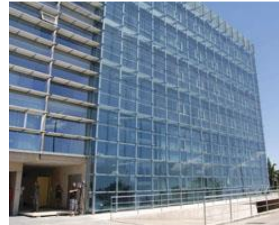
Imagen N.3 Reducción de las ganancias de calor con la implementación de aleros móviles Fuente: Revista Edificios de Alto Desempeño
