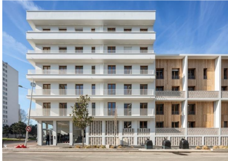
Gráfica 10: Fachada exterior de La Courneuve (Francia) Fuente: ( ArchDaily Colombia, 2019)
