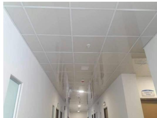
*Imagen.63: Cielo raso en PVC Fuente. Gypm&Plast Elaboración Gypm&Plast, (2017).*
