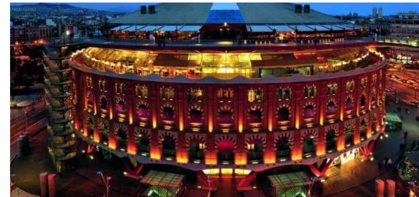
Imagen 23 Vista Nocturna centro comercial Las Arenas Fuente: (wikiarquitectura,2019)
