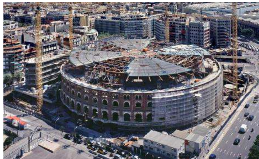
Imagen 20 Colocación de Cubierta en la plaza de Toros Las Arenas Fuente: (wikiarquitectura,2019)
