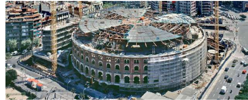
Imagen 53 Proceso de colocación de Cubierta en Centro Comercial Las Arenas Fuente: (wikiarquitectura, 2019)
