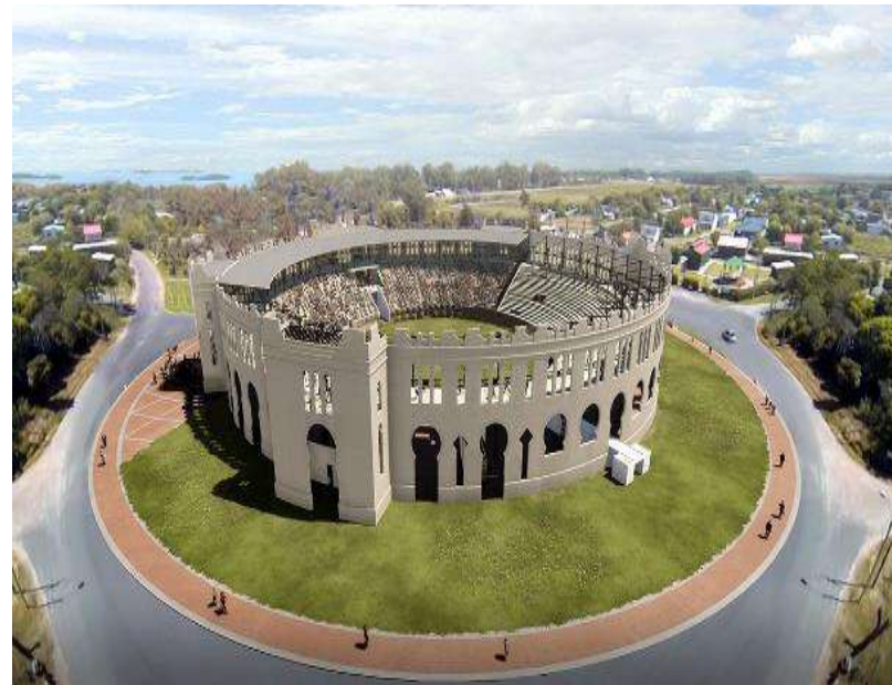
Imagen 34 Vista general Remodelación plaza de toros Real de San Carlos
