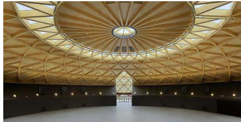
Imagen 21 Cubierta del Centro Comercial Las Arenas Fuente: (wikiarquitectura,2019)
