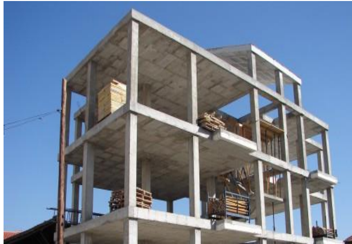
Imagen 12. Estructura de hormigón armado Fuente: goo.gl/jszg5o
