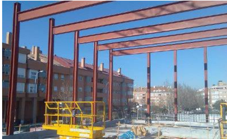
Imagen 29 Pórtico de estructura metálica. Fuente: http://www.structura2.es/page/6/
