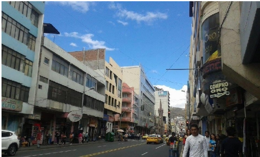
Imagen 42. Diferentes alturas de las construcciones en la Av. Cevallos Fuente: Ronnie Maximiliano Poaquiza Salazar
