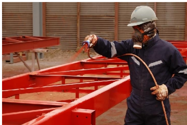
Imagen 26. Recubrimiento anticorrosivo estructura metálica. Fuente: goo.gl/aLFtUF
