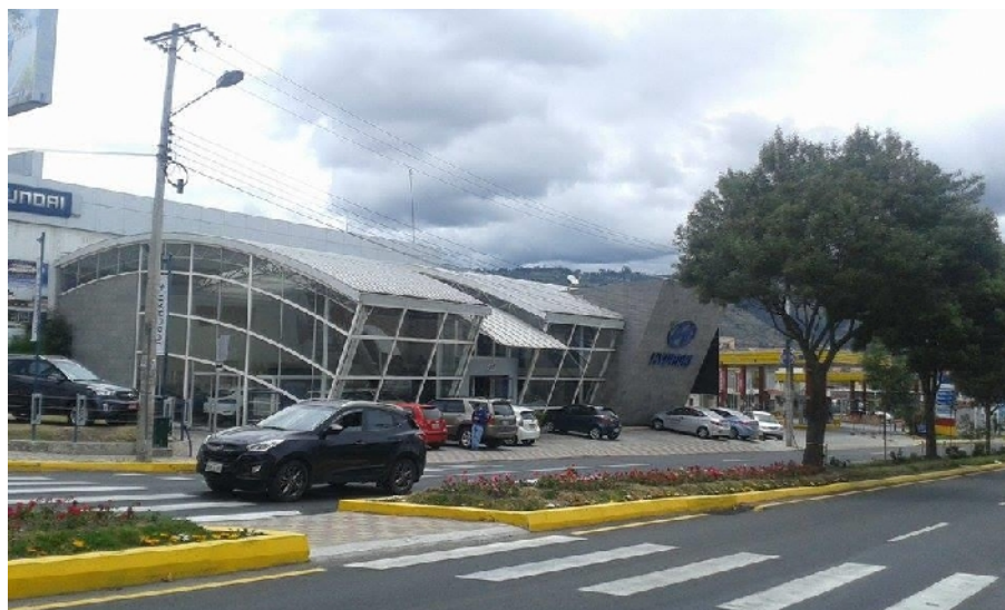
Imagen 49. Construcción metálica en la Av. Atahualpa Fuente: Ronnie Maximiliano Poaquiza Salazar
