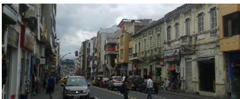
Imagen 45. Deterioro de edificaciones en la Av. Cevallos Fuente: Ronnie Maximiliano Poaquizza Salazar
