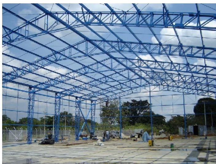
Imagen 27. Armazón estructural Fuente: goo.gl/yVs4Lg
