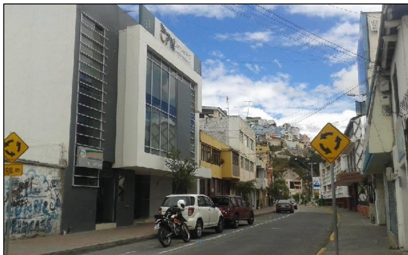
Imagen 38. Construcción metálica en la Av. Bolívar Fuente: Ronnie Maximiliano Poaquiza Salazar
