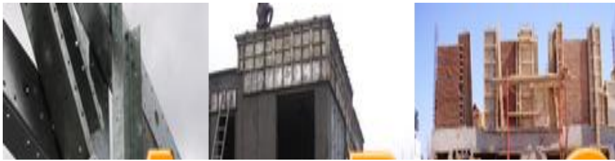
Imagen 7. Edificaciones con diferentes sistemas aplicados Fuente: goo.gl/ET0iyC
