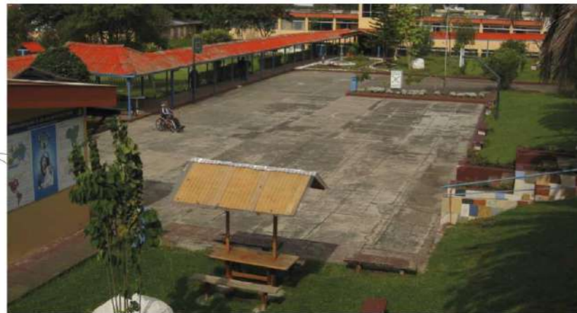
Imagen 50: Centro de atención para personas de la 3ra edad. Fuente: recuperado de Plataforma Arquitectura, 2015
