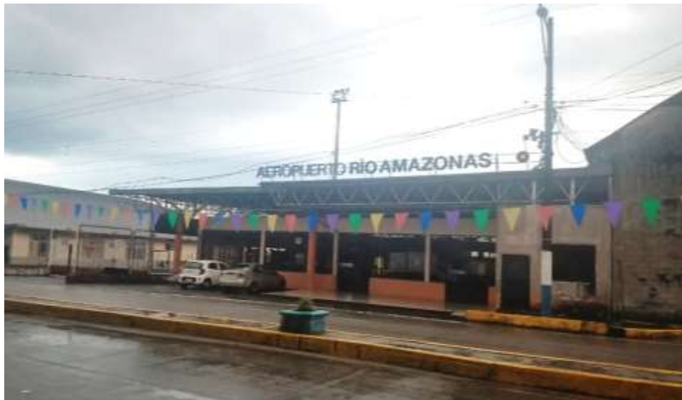
Imagen 14. Aeropuerto Río Amazonas
