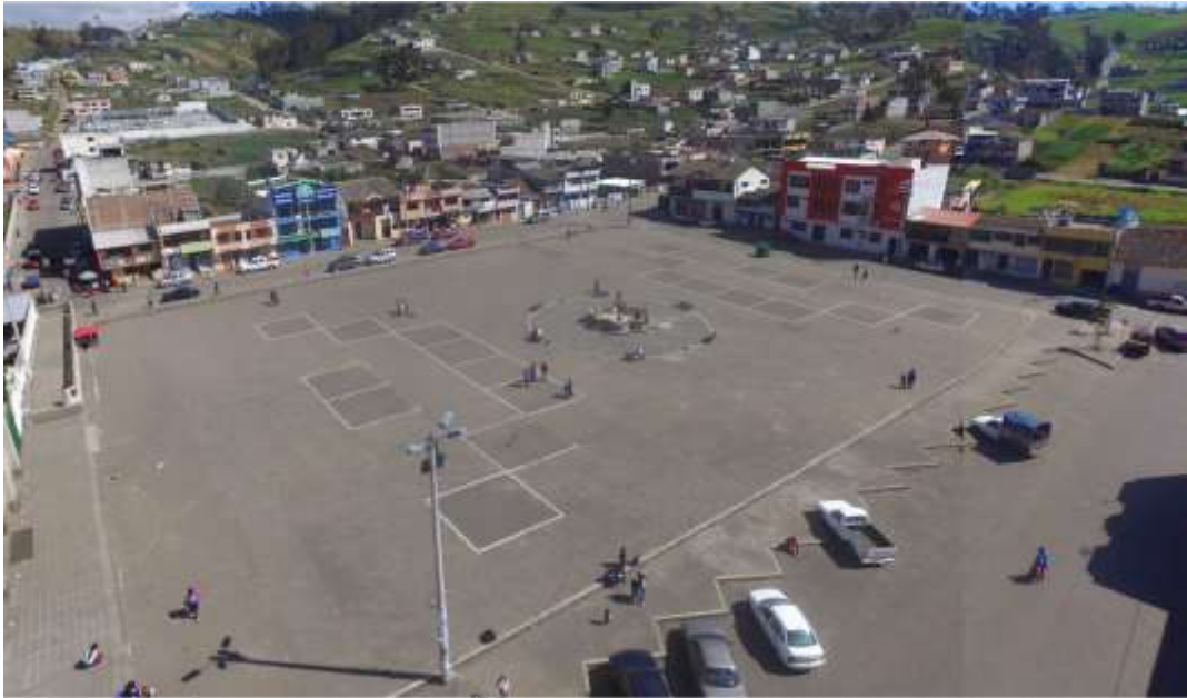
IMAGEN 5 ESTADO ACTUAL PLAZA
