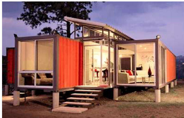
Ilustración 68. Construcción sobre pilotes.
