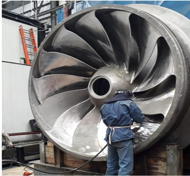
Imagen 14: Desbaste de soldadura de insertos.
