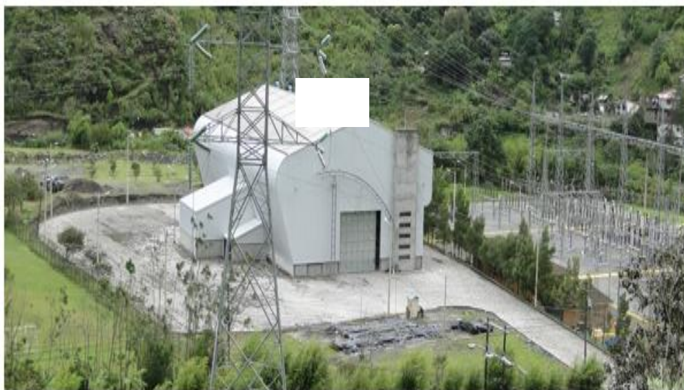
Imagen 1: Nave Industrial del CIRT.
