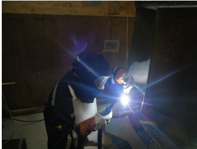
Imagen 10: Soldadura de relleno en talón de álabe y el filo de la corona del rodete.
