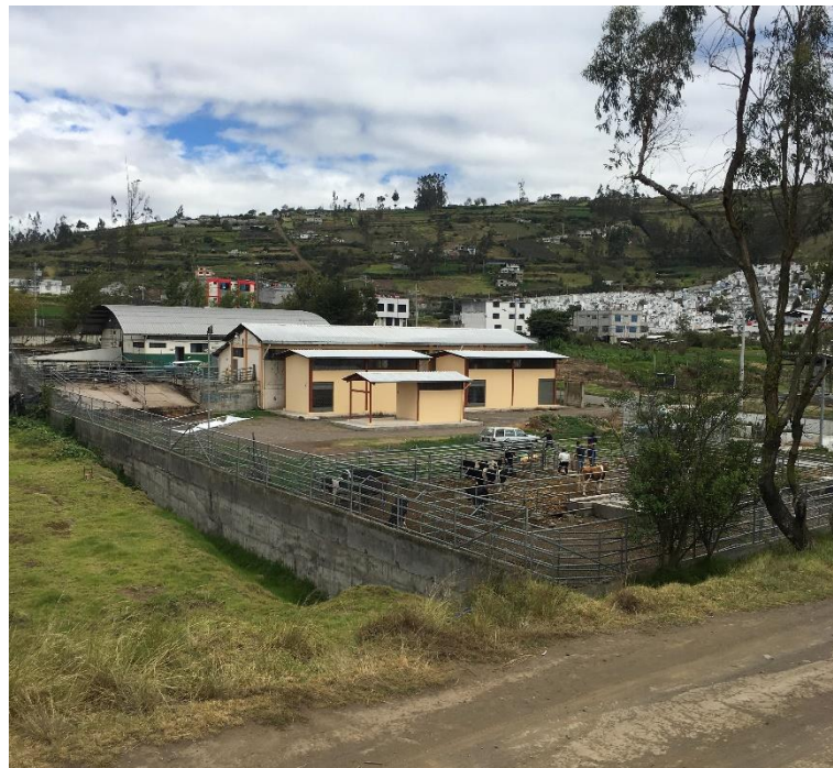
Imagen 33. Camal Municipal de San Pedro de Pelileo en zona residencial
