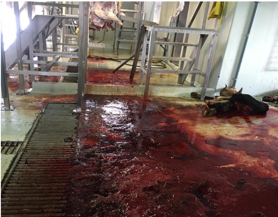
Imagen 10. Abastecimiento insuficiente de sumideros Elaboración propia
