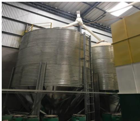
Anexo 12. Instalación de silo
