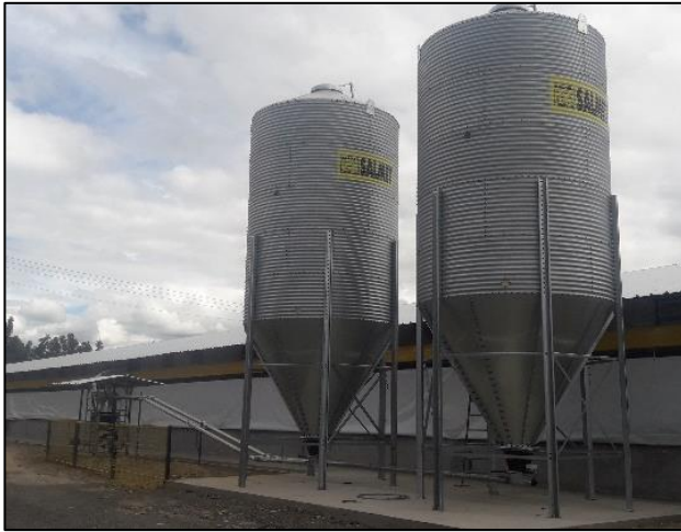
Imagen 5. Instalación de silos
