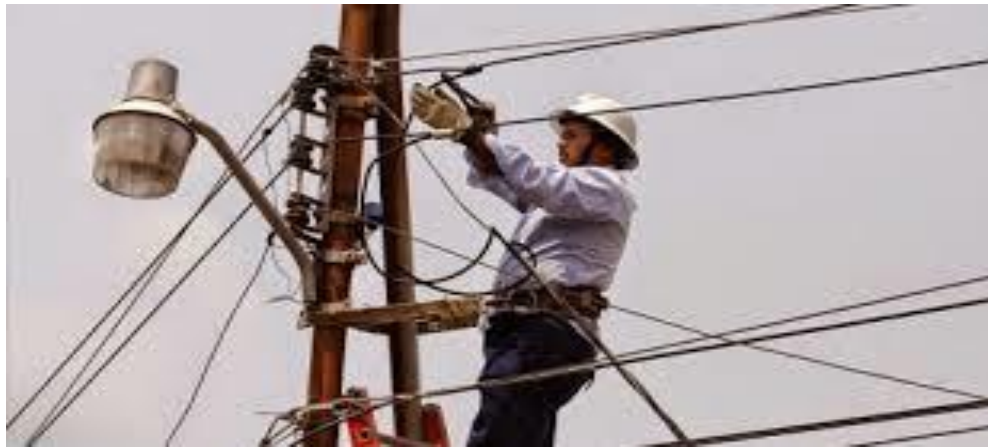
Figura 12: Ejecución de la instalación de medidores Fuente: ELEPCO S.A.
