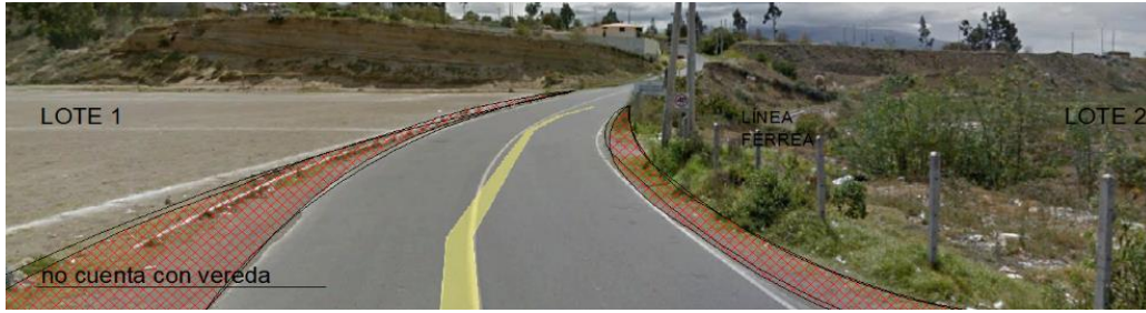
Imagen 96: Estado de vías de acceso a los lotes FUENTE: Elaboración Propia
