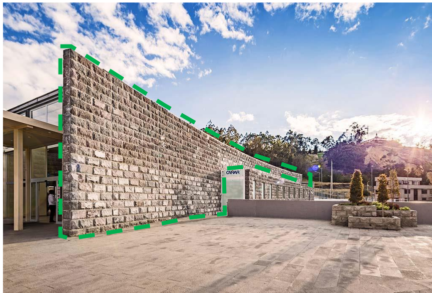
- - - - Muro de piedra (exterior)
