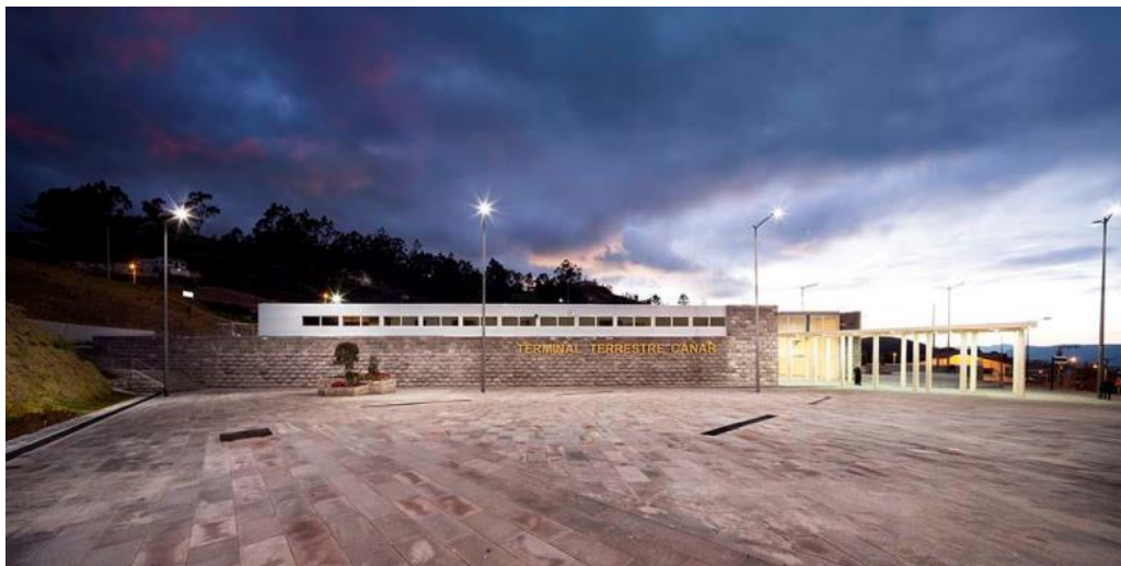
Imagen 12. Terminal terrestre de Cañar Fuente: Arquitectura panamericana
