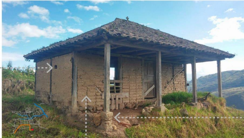
MURO DE ADOBE
