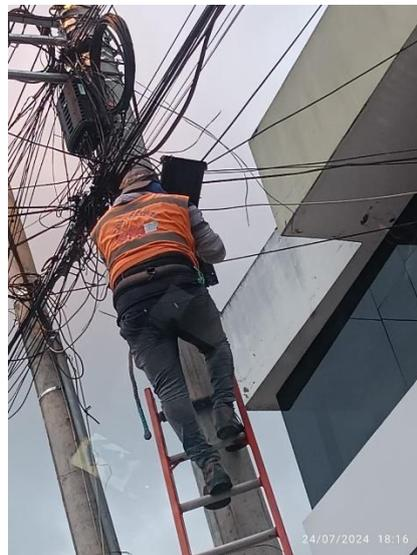
**Imagen 2.** Instalación de medidores eléctricos.
