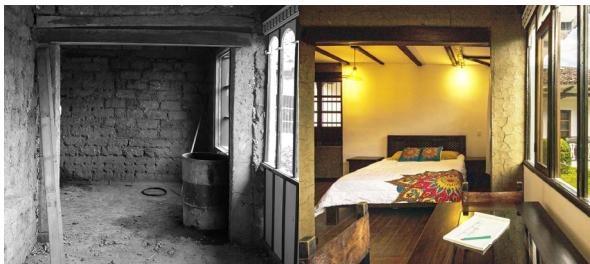
*Nota. Mantenimiento de muros, instalaciones eléctricas, reemplazo de elementos ruinosos y acabado de piso. (BAQ , 2020).*
