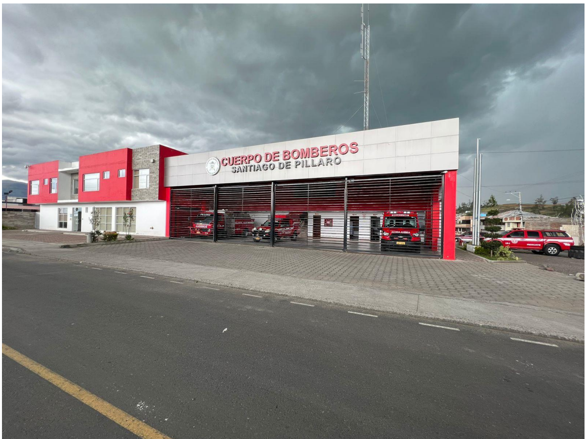
Imagen 1. Fachada principal del Cuerpo de Bomberos Santiago de Pillaro.
