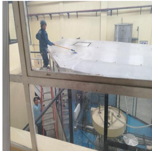
TRABAJOS EN ALTURAS
