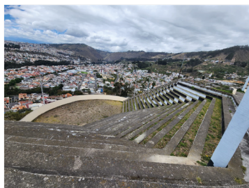
Infraestructura en desuso
