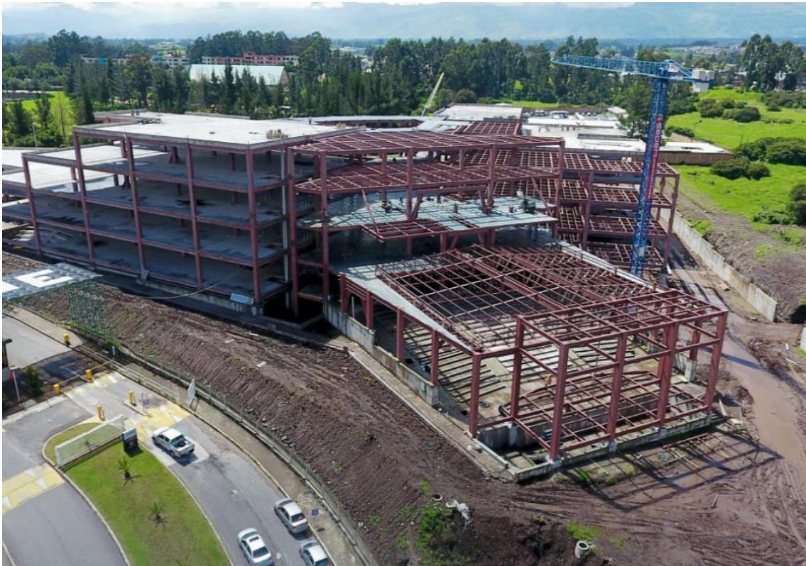
Figura 5. Montaje de una estructura. Nota. Montaje de estructuras.
