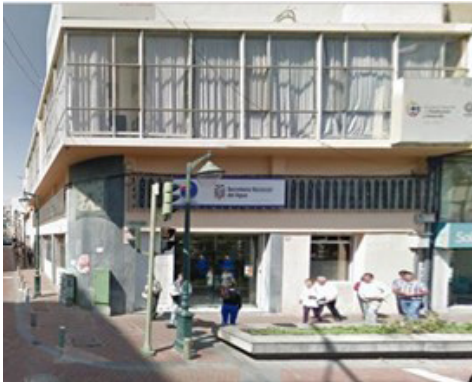
Edificio SENPLADES Año de construcción: 1970-1980
