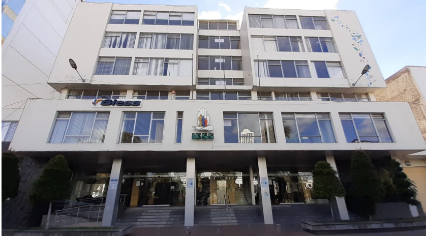
Vista entrada principal, calle Mariano Castillo
