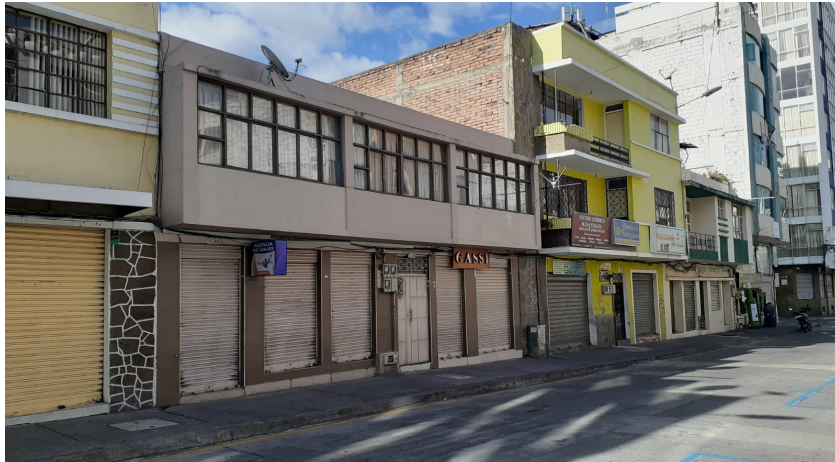
Vista lateral izquierda, calle Sucre
