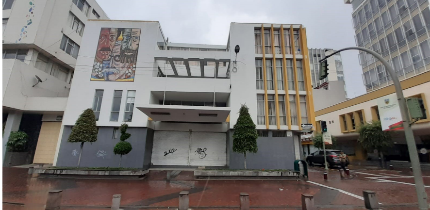
Vista entrada principal, calle Mariano Castillo
