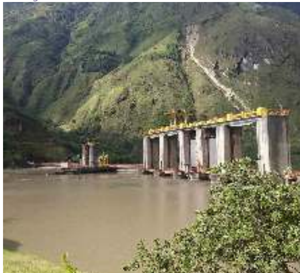
Nota: Central Hidroeléctrica Agoyán en la Ciénega, Baños de Agua Santa (2024)
